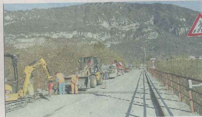
CANTIERE I lavori al ponte di Frassenè sono iniziati ieri
