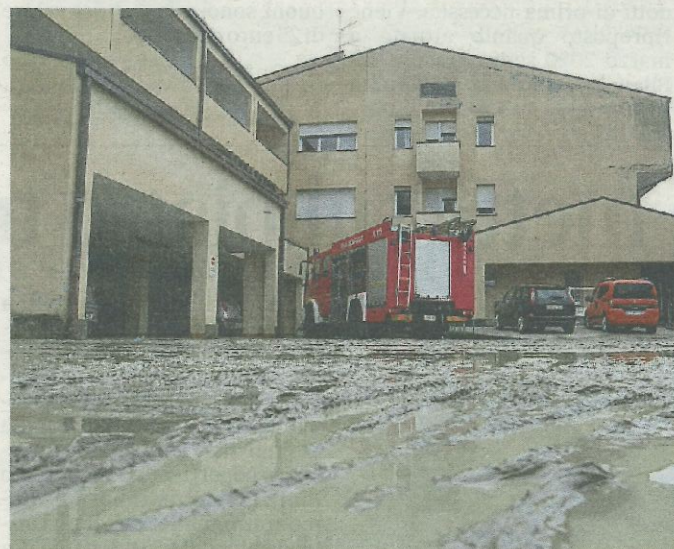
PUOS La struttura alluvionata con il maltempo del 5-6 dicembre
